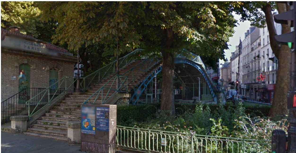
Pont de la Grange aux Belles, Paris
